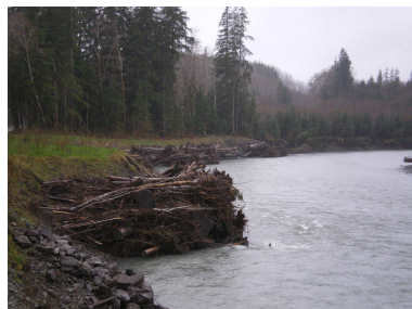
Fig. 22. - Defensa de una orilla en erosión a través de cepas y troncos ligados con cadenas (Hoh River, Washington, EE.UU).
