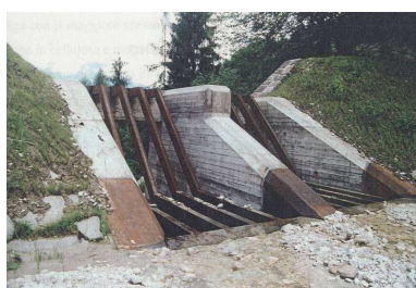
Fig. 18. - Dique selectivo con filtros a múltiple inclinación en el Río Fumola (Italia).
