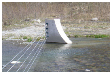
Fig. 19. - Contrafuerte central de un dique a cable en el Río Sarca (Italia).
