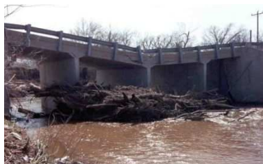
Fig. 7. - Los troncos acumulados aguas arriba de un puente han causado su rotura (Fuente: Bradley et al. , 2005).
